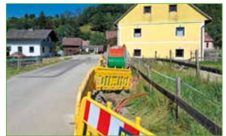
Die Glasfaserverkabelung hat in diesem Sommer Niederöblarn erreicht.
